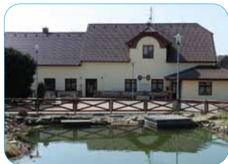
Obecní dům a víceúčelový sál v jednom
