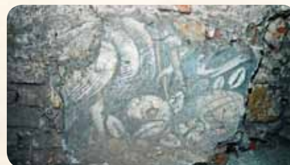
Zbytky výzdoby renesanční fasády ve výklenkové římsě jihozápadního a jižního paláce
