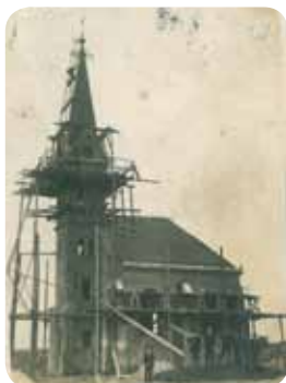
Stavba kaple na novém hřbitově, pohlednice ze sbírek Vladimíra Šulce.
